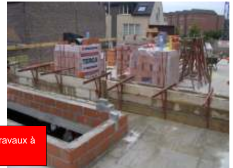
Placement du ferrailage pour la poutre en béton et placer le coffrage de rive pour la dalle de compression sur les hourdis et mettre en place les balustrades de sécurité
