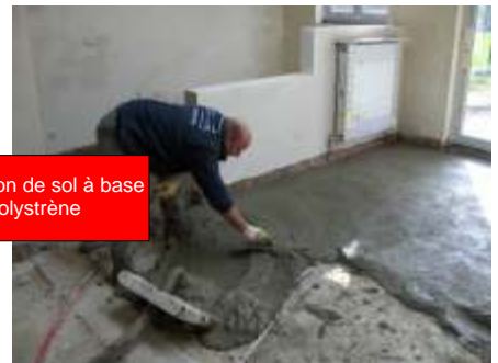
Placement d'un évidement pour le poêle en stéatite
