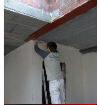
Travaux de plafonnage + plâtrage au grenier
