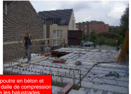
L'armature pour la dalle de compression est placée sur les hourdis par le conducteur de grue
