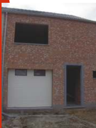
Placement de la porte de garage
